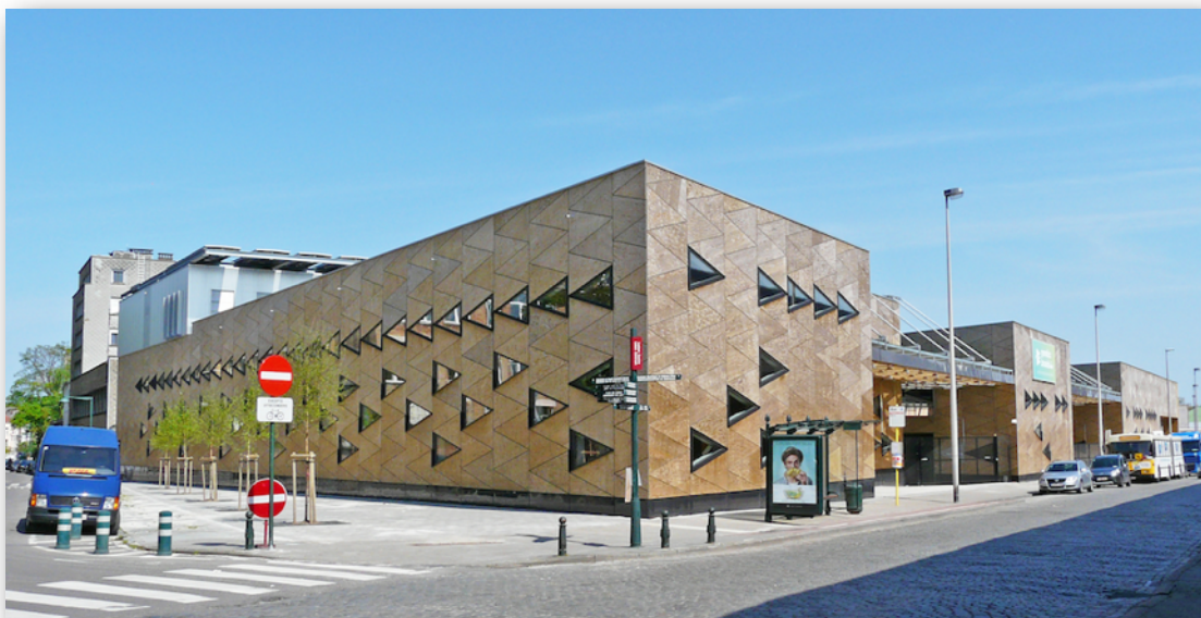
Figure 7. Partie « expansion économique » du quartier durable Tivoli. Bâtiment Greenbizz composé d'un incubateur d'entreprises à vocation environnementale, de bureaux et d'ateliers de production. Elaboré par les bureaux Architectes Associés, Setesco (stabilité), Istema - FTI - Cenergie (techniques spéciales), Daidalos Peutz (acoustique). Source : Architectes Associés
