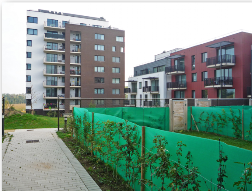
Figure 8. Projet rue Bruyn – site Bruyn Nord : brise-vue placés le long de jardins privés. Source: photo d'A.-L. Wibrin
